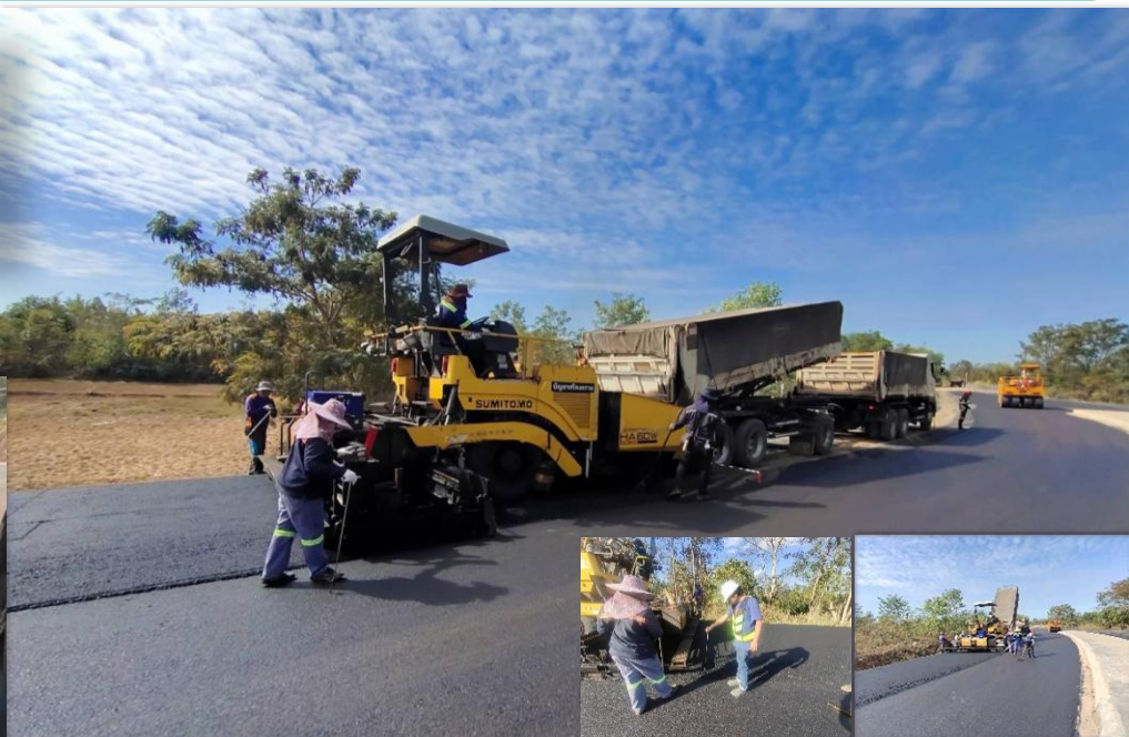
งานตรวจสอบงาน Prime Coat งานผิวจราจร Asphaltic Concrete Binder Course ๐.๐๕ ม. บริเวณ ทางแยก กม.ที่ ๙+๖๔๙.๐๐๐ เชื่อมกับทางหลวงชนบท หมายเลขนพ.๓๐๐๘ ตอนที่ ๑
